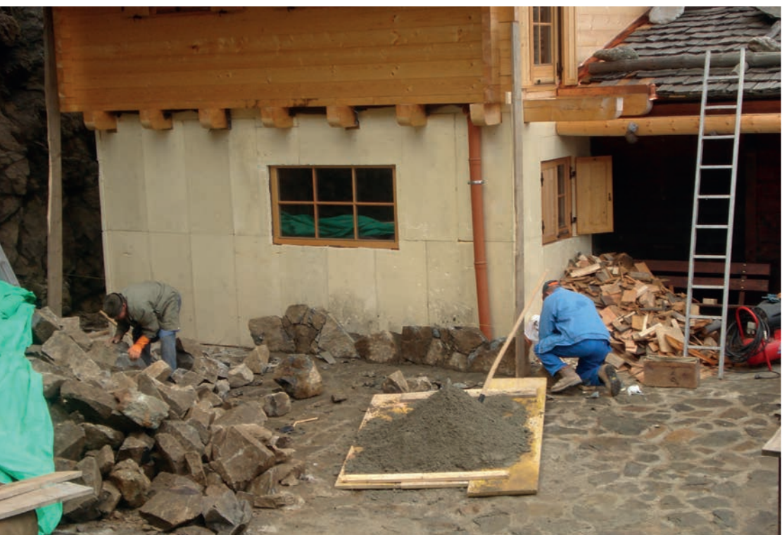
Betonieren der Umkleide 2006
